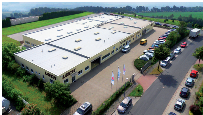
Werk Sachsen / Plant Saxonia Lichtenau/Chemnitz
